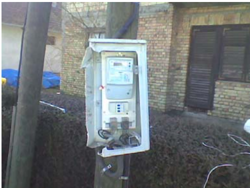
A) MEHANIČKI UNIŠTENO MERNO MESTO
